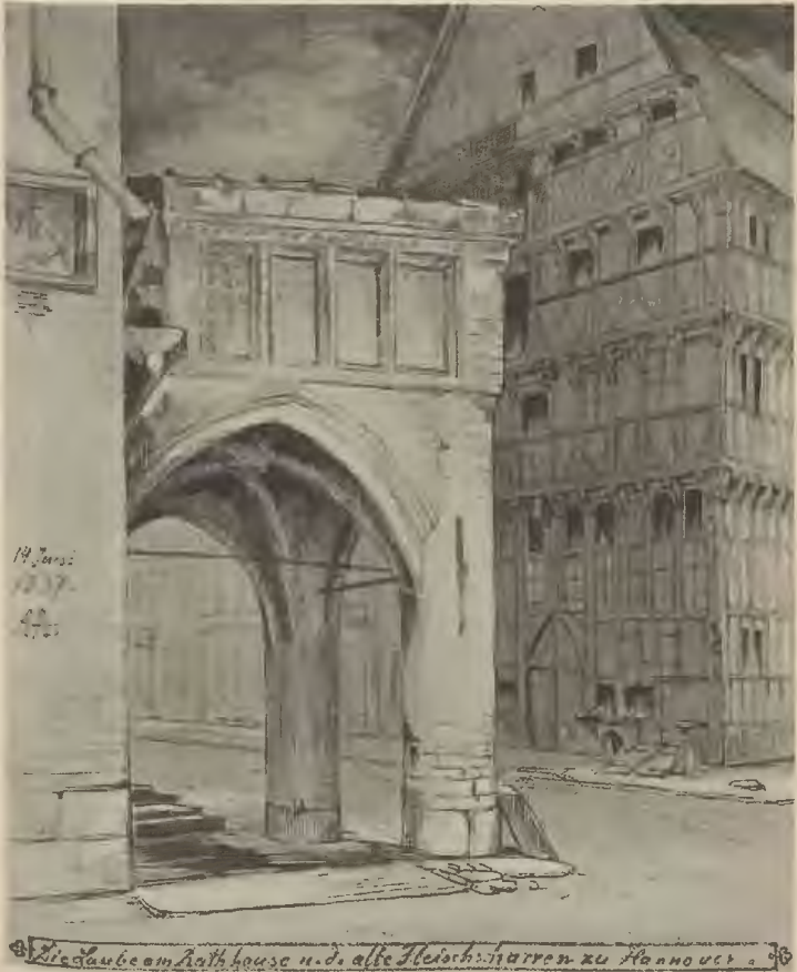
Blick auf das Fleischhaus (1541) vom Marktplatz.
