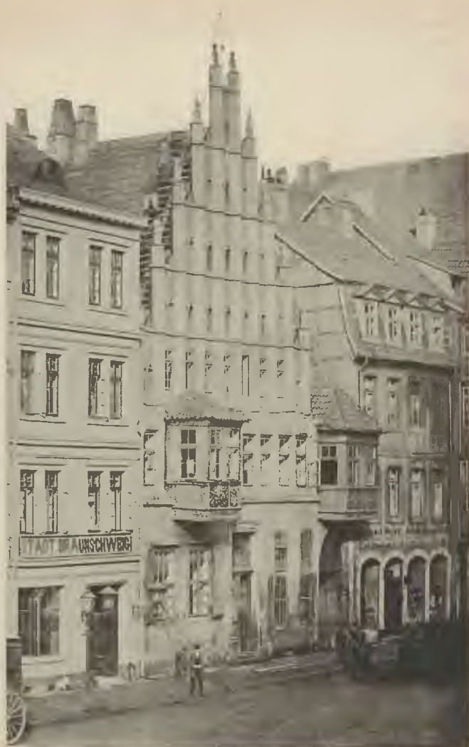
Bürgermeisterhaus Schmiedestraße 14 beim Abbruch, gotischer Backsteingiebel wie am alten Ratthause, Zutaten der Renaissance.
