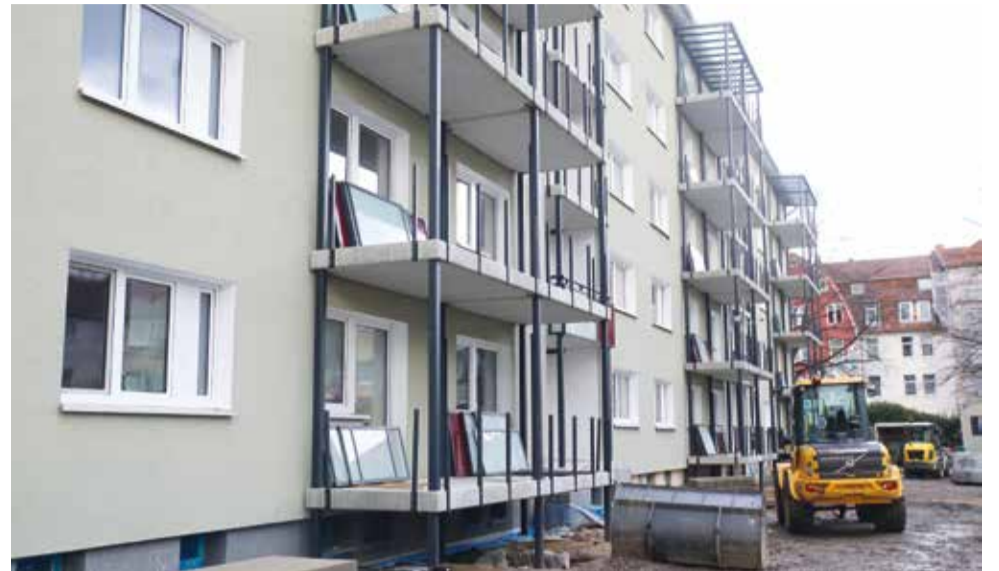
Dämmungen und neue Balkone: Das Wohnungsunternehmen hanova sanierte mehrere Gebäude. (Fotos: Hoff)
