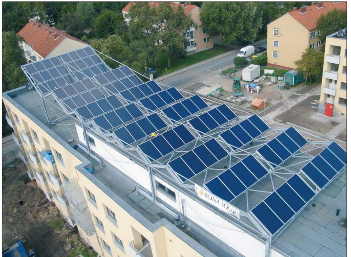
Hilft die Energiekosten zu senken: Auf dem Dach der Magdeburger Straße 2 und 4 sind 135 Quadratmeter Solarkollektoren installiert.
