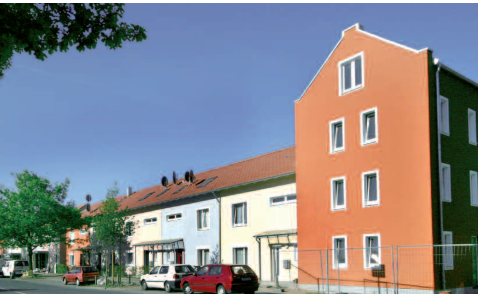
Bunt und neu: Farbenfrohe Reihenhäuser entstehen an dem Platz, an dem vormals die Hochhäuser standen.
