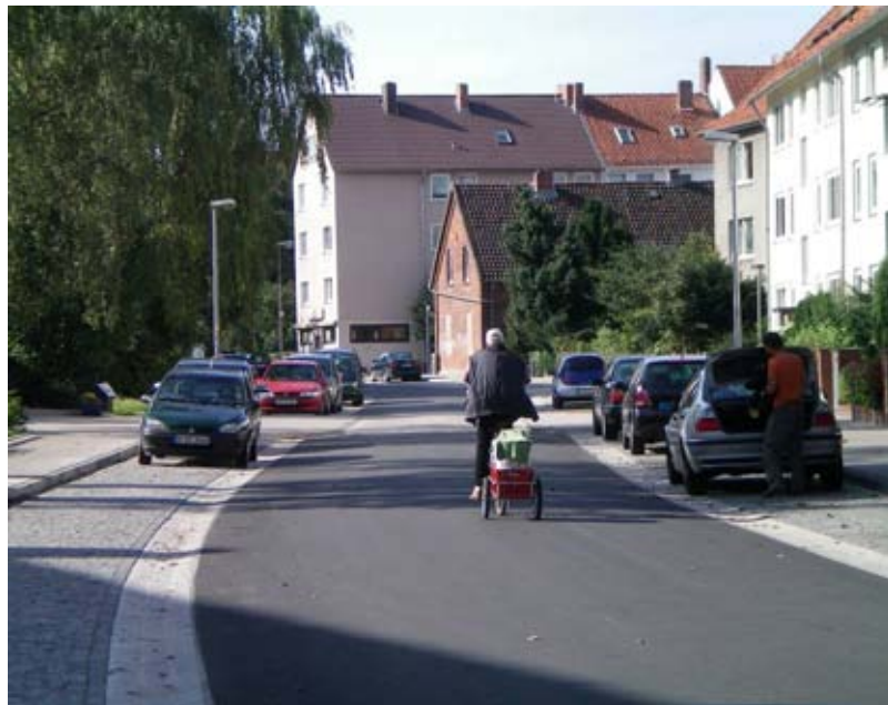
Fertiggestellter 1. Bauabschnitt Freudenthalstraße
