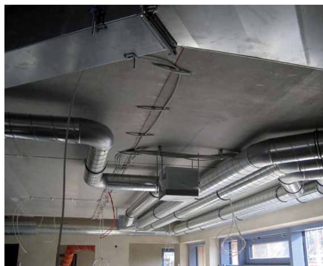
Passivhaus-Lüftungsanlage mit variablen Temperaturen und Luftmengen für 5 Raumzonen
