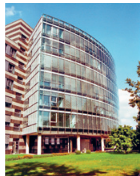
Bürogebäude der ehemaligen Philipp Holzmann AG
