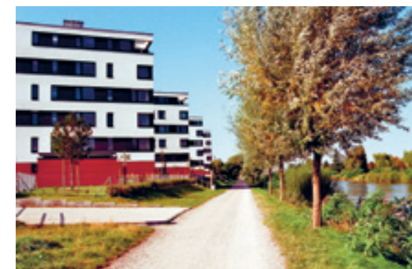
Fassade der Grachtenhäuser (oben)
