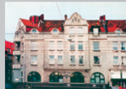
Genossenschaftsbau vor der Sanierung, Stand 1998 (oben) Giebel nach der Sanierung (unten)
