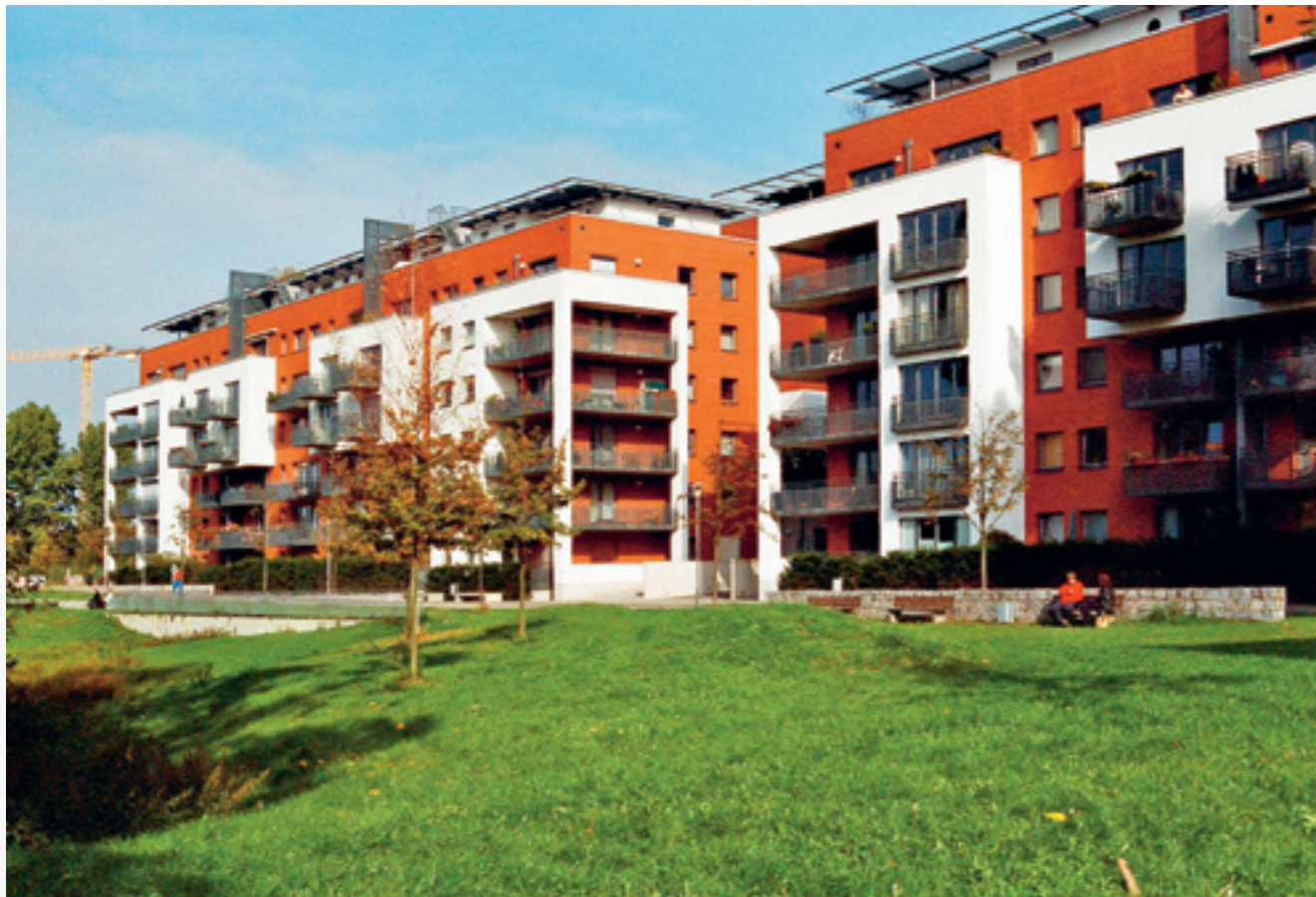
Wohnungsbau im Pelikan-Viertel am „Tintengraben“
