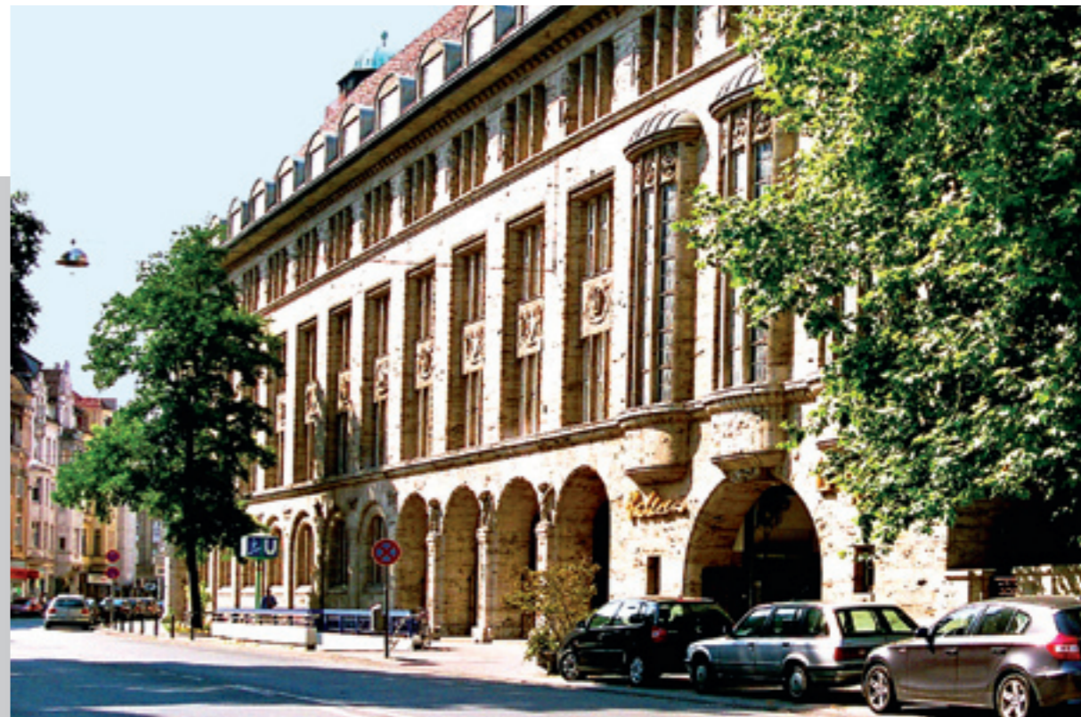
Das seit 1978 unter Denkmalschutz stehende Stammhaus von Bahlsen zählt zu den architektonisch herausragenden Zeugnissen des Jugendstils in Hannover.
