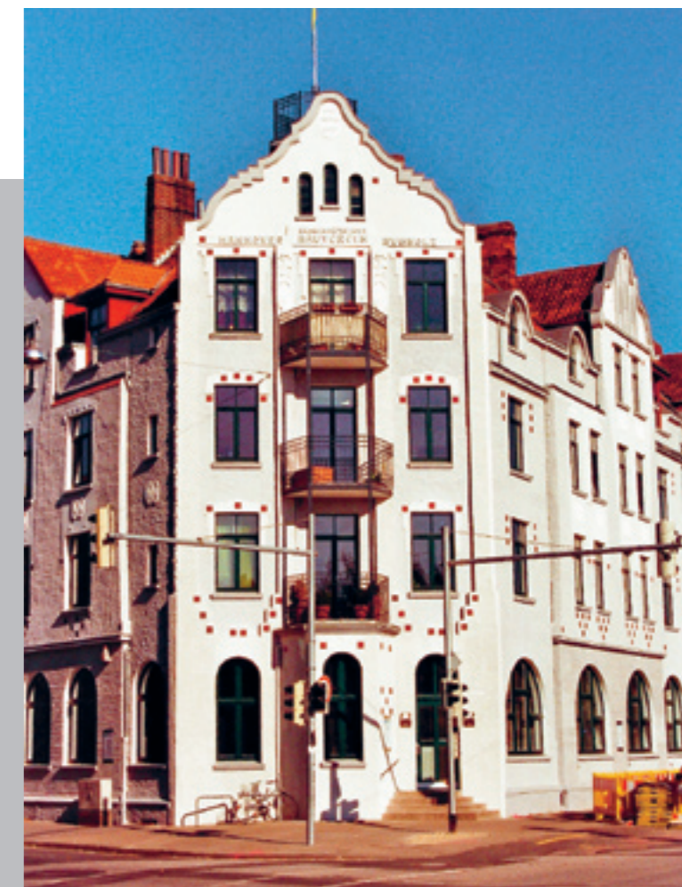
Wiederherstellung der Fassade, Giebel und Balkone, Stand 2007
