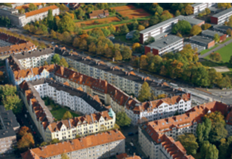
Blockbebauung Spannhagenstraße mit genossenschaftlichem Wohnungsbau – erbaut 1906–07
