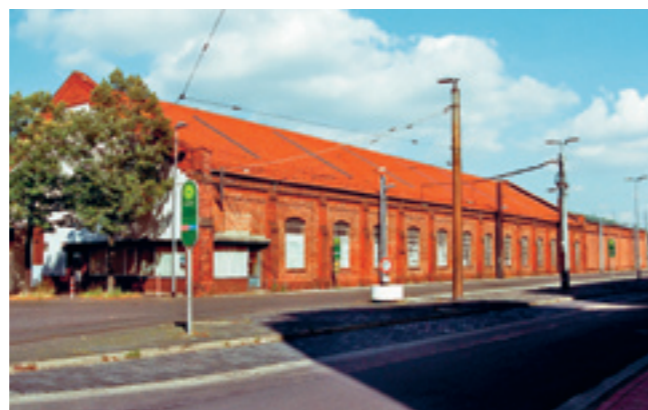
Die ehemalige Straßenbahnbetriebshalle der Ústra soll in Kürze zur Erweiterung des Einkaufszentrums umgebaut werden – die Fassade der Halle wird rekonstruiert
