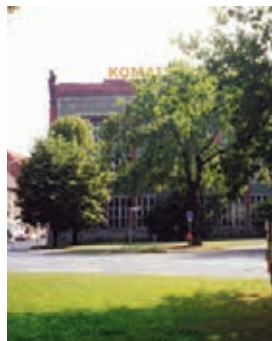
Ehemalige „Hanomag“ am Deisterplatz
