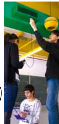
Energiemessung in der IGS Mühlenberg
