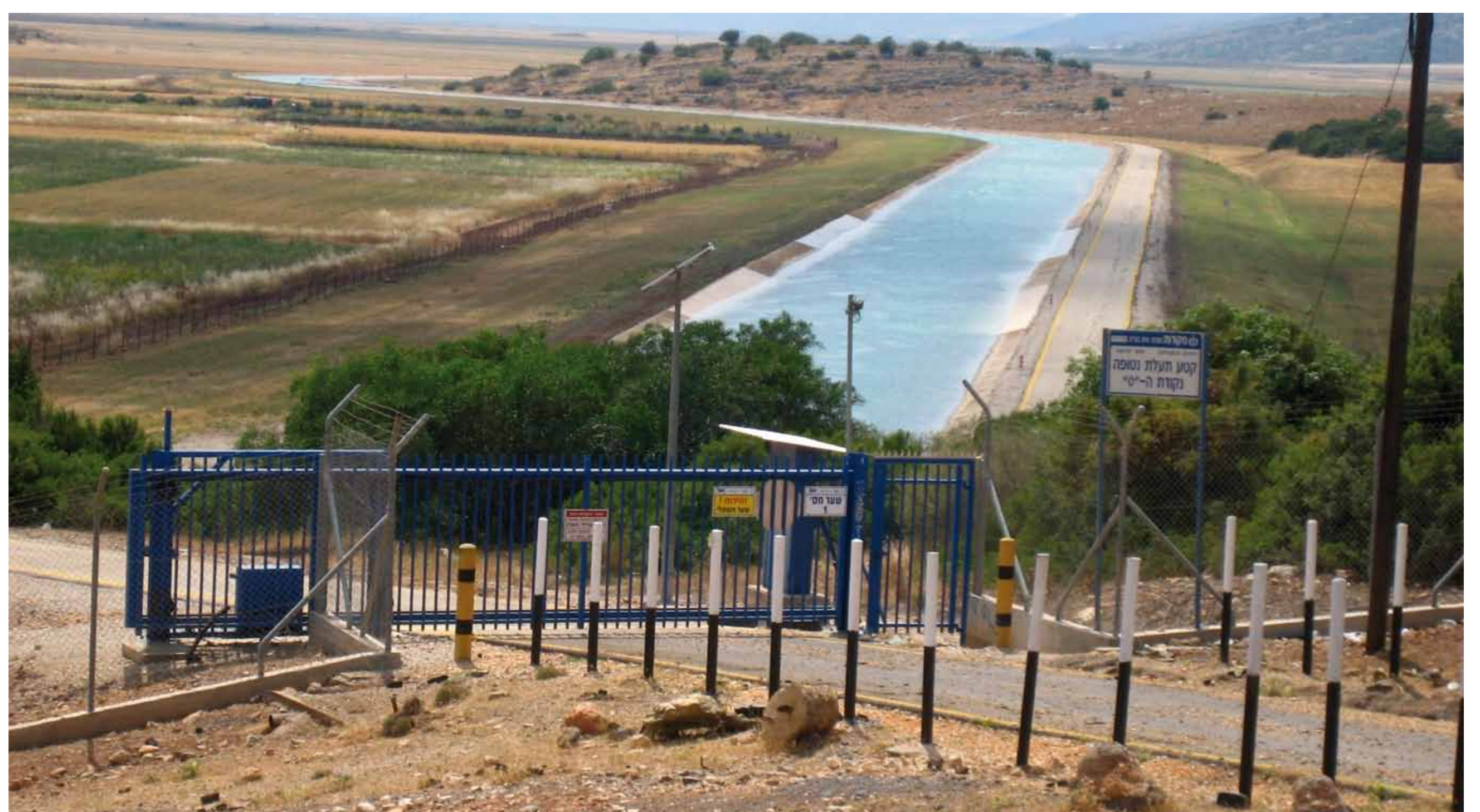
National Water Carrier See Genezareth-Negev: Wasseraustritt aus der unterirdischen Leitung in den offenen Kanal bei Elabun ins Beit Netofa Tal.
