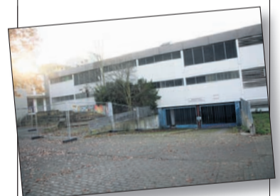
Soll in Kürze abgerissen werden: Die alte Hochgarage zwischen den Terrassenhäusern und dem Neubaugebiet Holz-wiesen.
