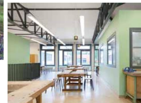
Für den Einzug des Werkraums samt Maschinen und Materiallager wurde der nicht mehr benötigte Kohlenbunker am südlichen Gebäudeende hergerichtet: Auf Erdgeschossniveau wurde eine Stahlbetondecke eingezogen; die Stahlfachwerkträger des Dachs sind sichtbar gelassen, ebenso das Mauerwerk der Wände, das lediglich weiß geschlämmt wurde. Durch die Zugänge zum Hof kann der Werkunterricht bei schönem Wetter auch nach draußen verlagert werden.
