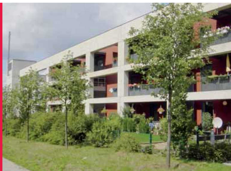
Eigentumswohnungen im Kirchenzentrum Owner-occupied apartments in the church centre
