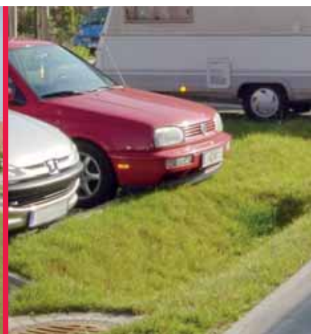
Entwässerung im Straßenraum Roadside drainage
