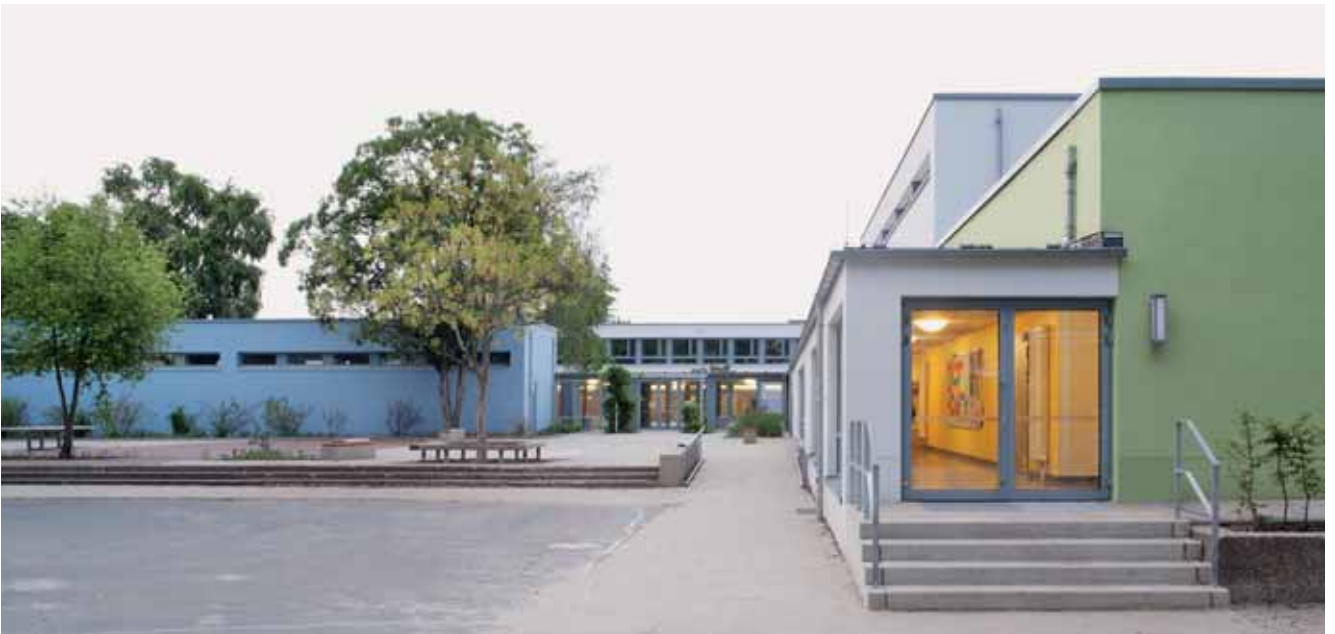
Brüder-Grimm-Schule in Hannover-List nach der Sanierung | Brüder-Grimm school in Hannover-List after refurbishment
