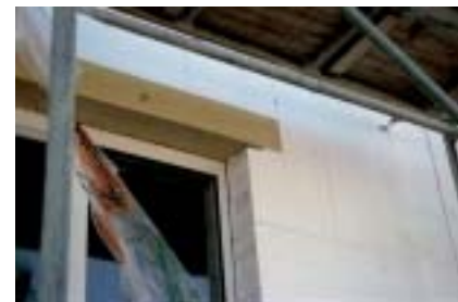
DÄMMUNG IM FENSTERBEREICH INSULATION AROUND A WINDOW
