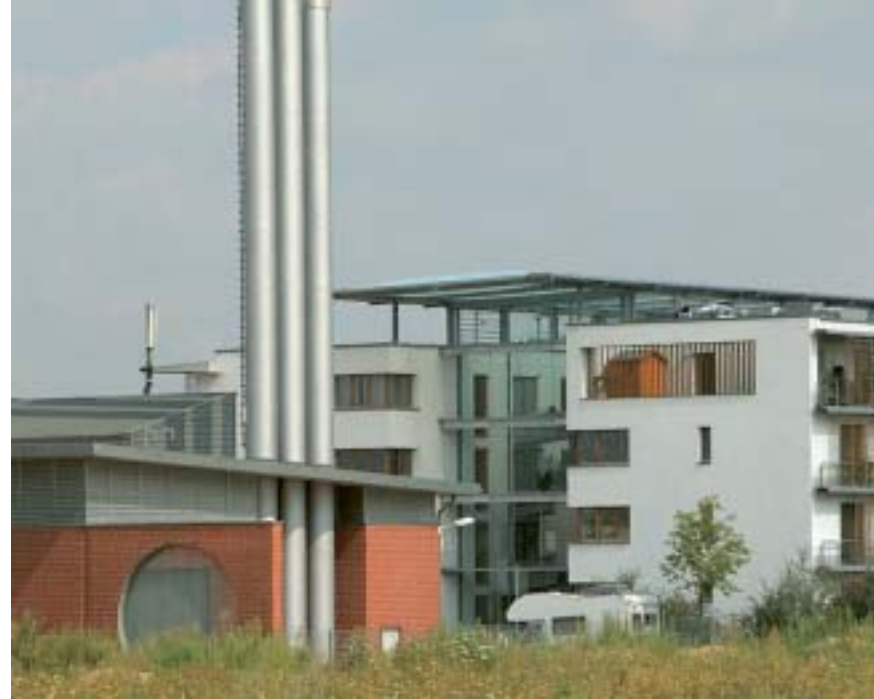
ENERGIEZENTRALE | ENERGY CENTRE STADTWERKE HANNOVER AG
