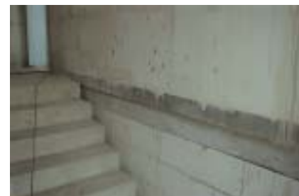
GEDÄMMTER STEIN IM SOCKELBEREICH SUPERINSULATION BRICKS
