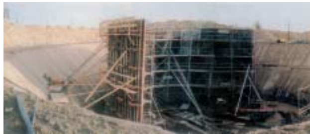
SPEICHER IM BAU THERMAL STORAGE TANK UNDER CONSTRUCTION
