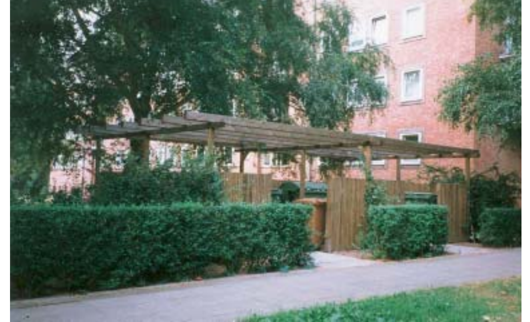
ABFALLSAMMELPLATZ WASTE COLLECTION POINT
