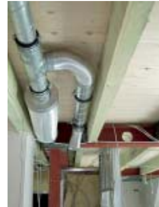
FRISCHLUFTHEIZUNG MIT WÄRMERÜCKGEWINNUNG FRESH INCOMING AIR WARMED BY HEAT RECOVERY UNIT
