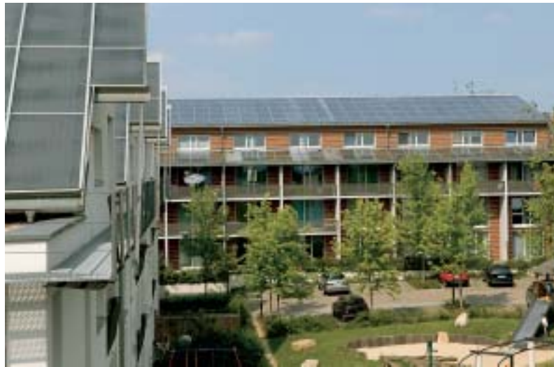
SOLARKOLLEKTOREN | SOLAR THERMAL COLLECTORS
