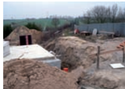
Auf dieser Baustelle ist kein Quadratmeter unberührt geblieben.
