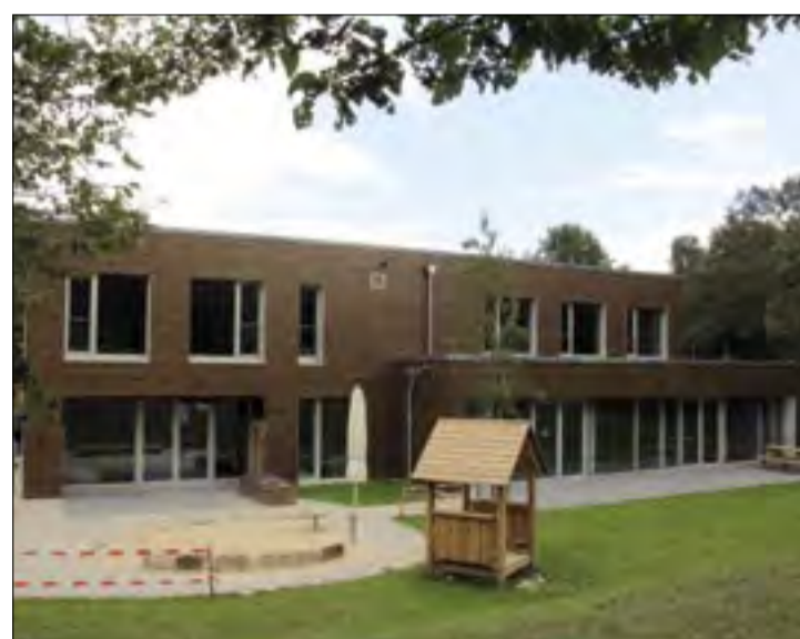
Die städtische Kita Hogrefestraße ist umgeben von einem großen Freigelände.
