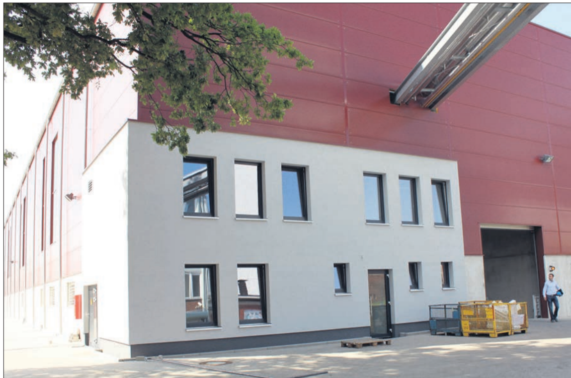
Die neue Kornhalle: Aus dem Neubau heraus werden die Produktionsanlagen der VSM auf dem Gelände an der Siegmundstraße zeitgenau mit Schleifkorn beliefert. Foto: VSM AG
