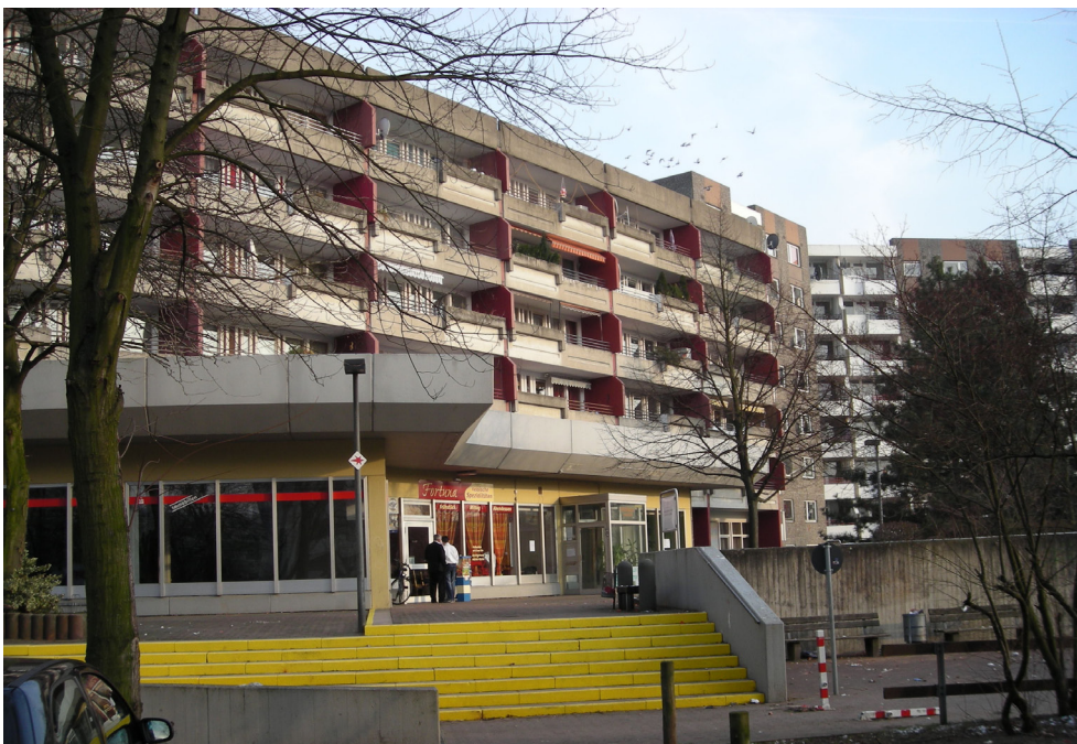
Betonbarrieren am südlichen Bereich des Einkaufszentrums
