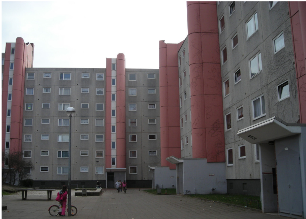
Hauseingangsbereiche Wohnhof Spessartweg
