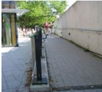
Außenrampe im tiefergelegenen Schulhofbereich
