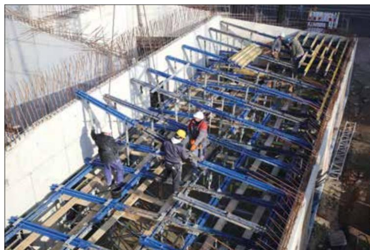
Bevor die Betondecken gegossen werden können, muss eine Stahlkonstruktion errichtet werden. Sobald das Material ausgehärtet ist, können die Träger entfernt werden.
