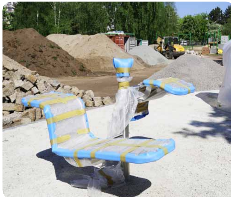
Schon vor einem Jahr wurden die Geräte aufgestellt.
