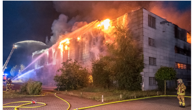
Nach der Durchzündung des Pavillons drohten die Flammen auf drei benachbarte Gebäude überzugreifen (Foto: Uwe Dillenberg)
