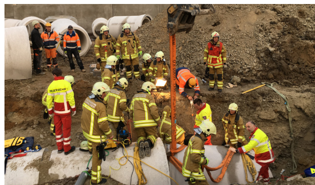
Rettungskräfte bei der Befreiung des Bauarbeiters (Foto: Feuerwehr Hannover)
