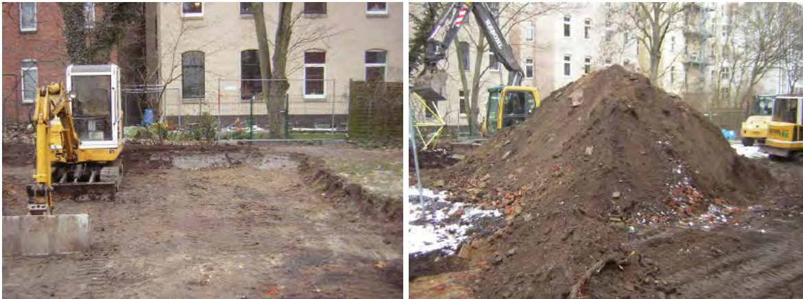
Umsetzung Sanierung 2013, Abtragsbereich (links) und Aushubmaterial mit Bauschuttbeimengungen (rechts)
