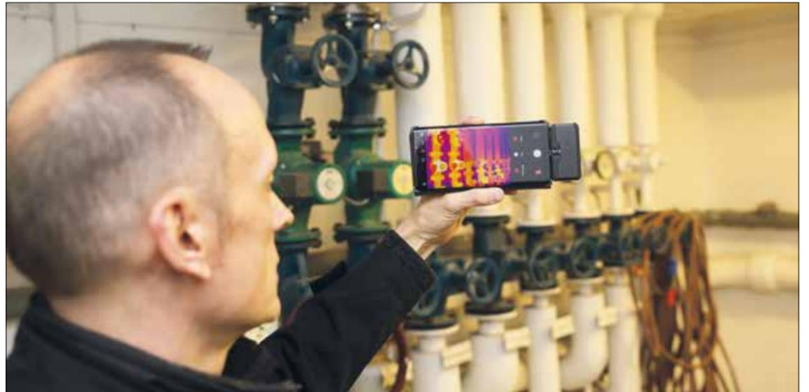
Die Wärmebildkamera von Carsten Bremer bringt es ans Licht: An den ungedämmten Heizungsrohren geht viel Wärme verloren – insbesondere an den Übergängen. Zu sehen ist das an den roten und gelben Flächen. Hauseigentümer Günter Benecke will die Schwachstellen beheben lassen. (Fotos: Hoff)
