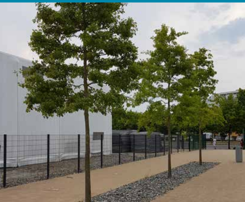
Fotos | Links: Baumrigole • Rechts: Mulde Straßenentwässerung
