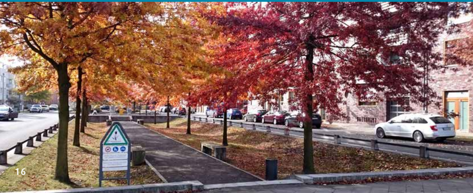
Foto | Mulde Straßenentwässerung
