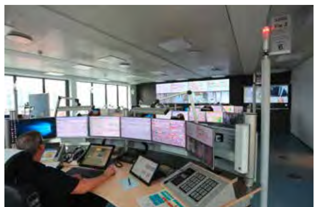
Außenansicht und Einsatzplätze in der Redundanzleitstelle in Stöcken (Fotos: Feuerwehr Hannover)
