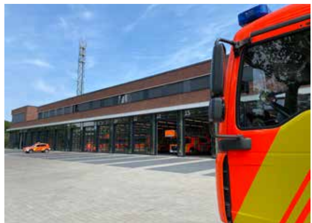
Das Wachgebäude des neuen Standorts der Feuer- und Rettungswache 3 (Fotos: Feuerwehr Hannover)
