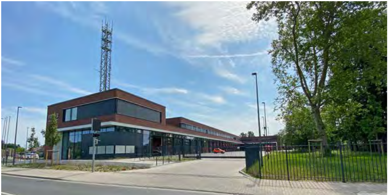
Außenansicht des Wachgebäudes der neuen Feuer- und Rettungswache 3 (Foto: Feuerwehr Hannover)
