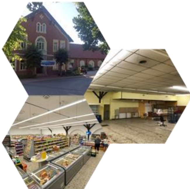
Außenansicht Dorfladen innen vor der Sanierung
