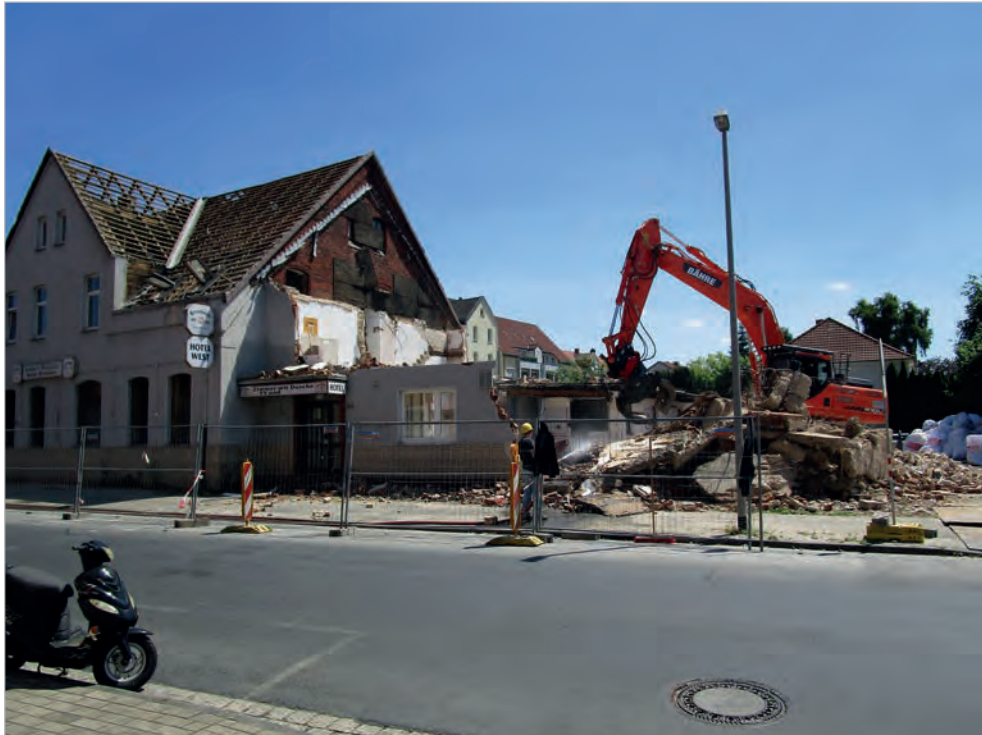
Rückbau des seit langem leerstehenden Hotel West (LHH)
