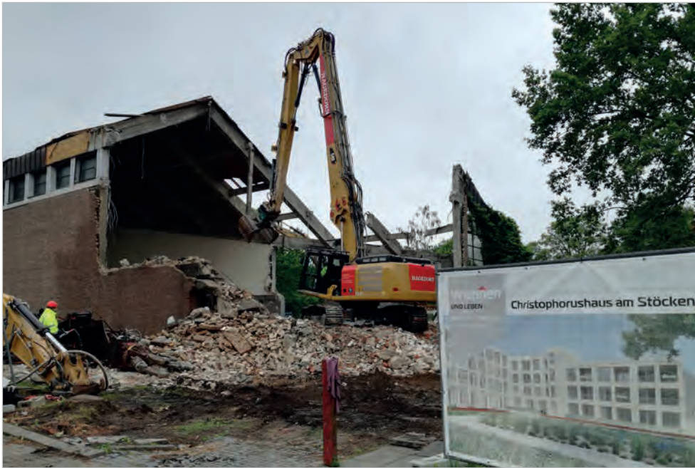
Rückbau Christophorus (LHH)
