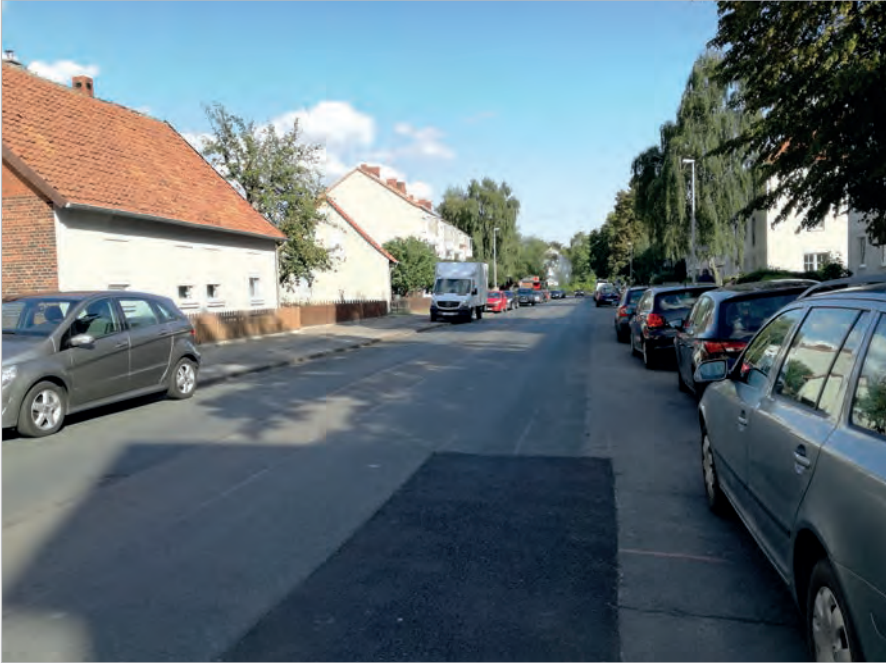
Eine Grunderneuerung der Weizenfeldstraße ist notwendig (LHH)
