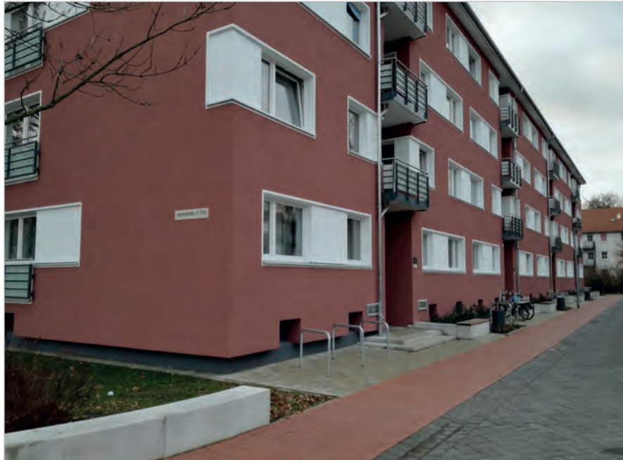
Hogrefestr. 17, 17 A - C nach der Erneuerung der Fassaden (LHH)
