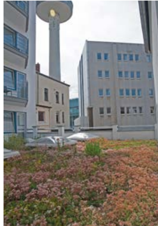
Abb. 46: Relativ artenreiches Gründach eines Hotels in isolierter Innenstadtlage mit ergänzender Staudenpflanzung © Rolf Witt
