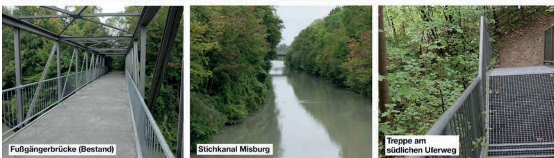
Abb. 86: Bestandssituation Brücke (Fotos: plan zwei)
