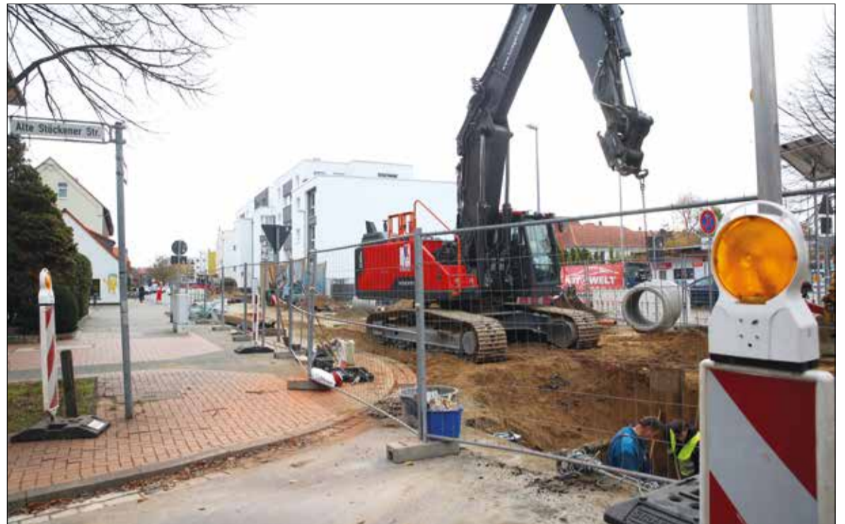
Der erste Bauabschnitt erfolgt zwischen der Alten Stöckener Straße und der Broyhanstraße. Die Arbeiten führen zu Einschränkungen im Verkehr. Auch die Buslinie 126 nimmt einen anderen Fahrweg. (Foto: Hoff)
