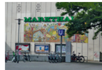
Oben: Kiosk am Aegidientorplatz Unten: Markthalle
