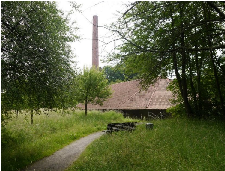
Ehemalige Kalkbrennerei im Willy-Spahn-Park
