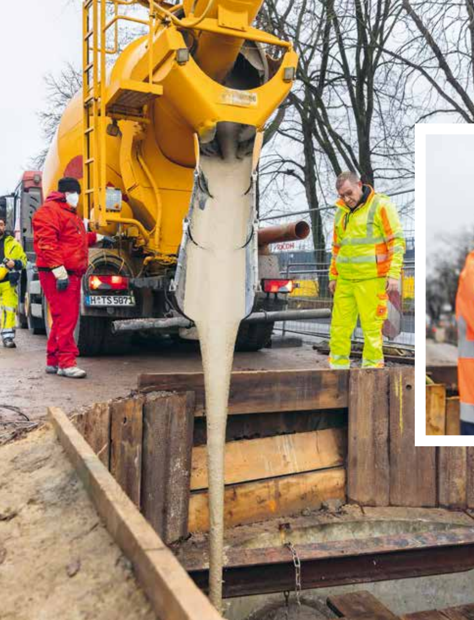
Alles unter Kontrolle: Sven Kuschla, Sachgebietsleiter Kanalbau (oben links), und sein Kollege Christian Heidorn verschaffen sich einen Überblick auf der Baustelle. Später verfüllt ein Mischlaster die Baugrube mit einem Mineralgemisch.
