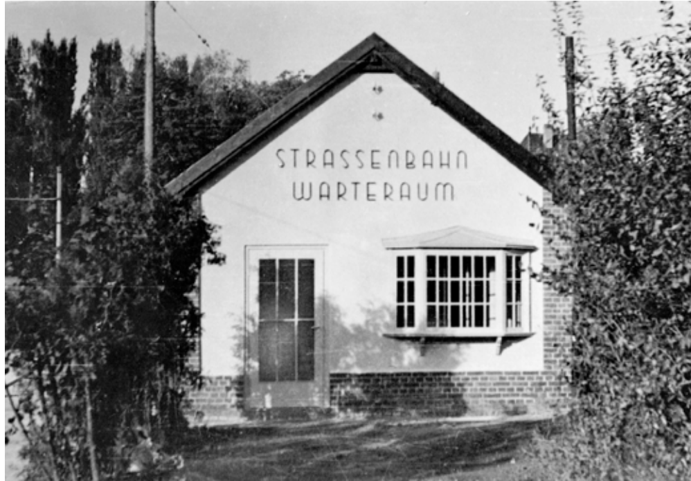
„Straßenbahn-Warteraum“ an der Endstelle Landwehrschanke im Jahr 1949: Das kleine Gebäude umfasste auch einen Dienstraum für das Personal. Im Hintergrund der Ricklinger Friedhof. Quelle: ÜSTRA-Archiv
