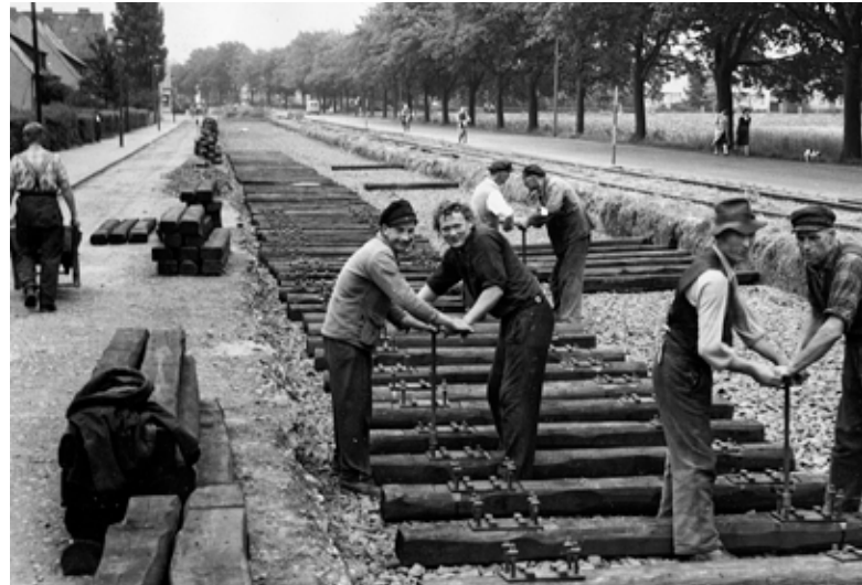
Gleisbauarbeiten kurz vor der damaligen Wendeschleife Oberricklingen an der Wallensteinstraße. Heute beginnt etwa hier die Tunnelrampe Richtung Mühlenberg. Quelle: ÜSTRA-Archiv (Wilhelm Hauschild)
