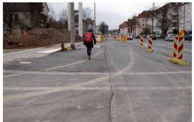
Göttinger Chaussee, März 2019, Beginn der Bauarbeiten
